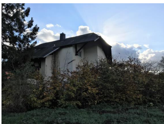
Figure 2.9: Haie des bords de champs de plain-pied (au nord-ouest de l'habitation qui se trouve le long de la N7)
