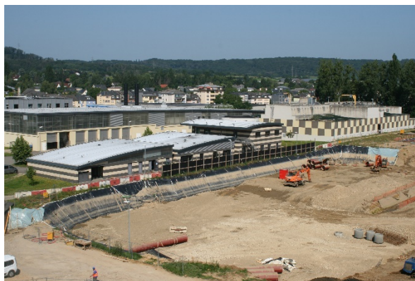
Vue à partir du sud-est du site vers le nord-ouest sur le bâtiment administratif actuel
