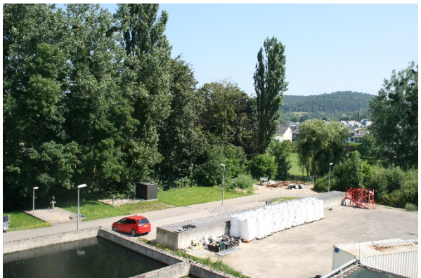
Vue sur la partie nord-est du site
