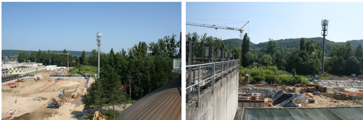
Vue sur l'antenne depuis le sud-est du site
