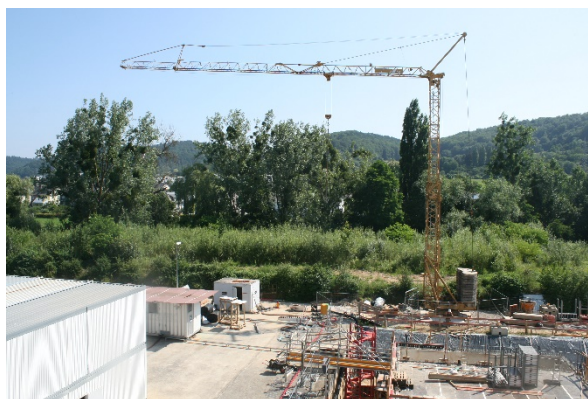
Vue sur le terrain au nord-est du site
