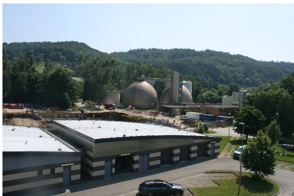
Vue depuis le côté ouest du site vers les deux tours qui servent à la fermentation, au sud-est du site de la STEP
