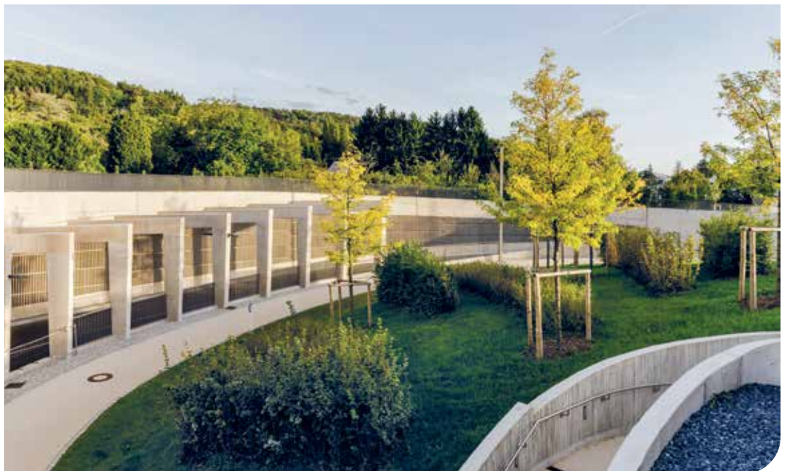
Chemin piéton rue Prince Henri à Helmsange
