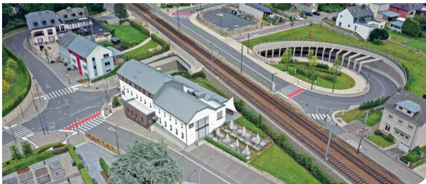
▀ Tunnel PN17 à Walferdange
