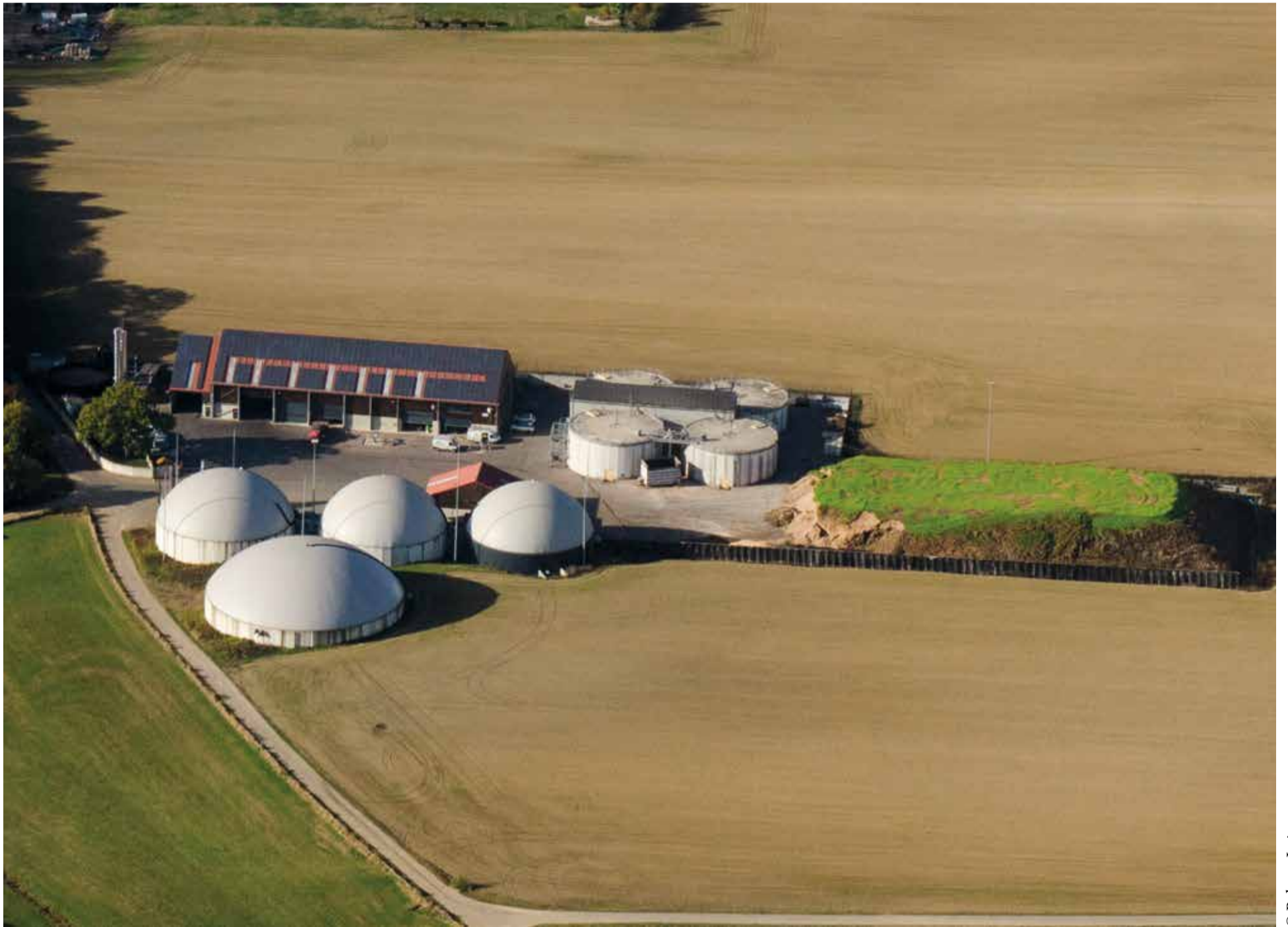
Le site de Bakona vu du ciel : les dômes sont les cuves de fermentation où est produit le biogaz qui sera ensuite purifié avant d'être injecté dans le réseau distributeur. Die Bakona-Anlage von oben: Die Kuppeln sind die Gärtanks, in denen das Biogas erzeugt wird. Dieses wird anschließend gereinigt, bevor es in das Verteilernetz eingespeist wird.
